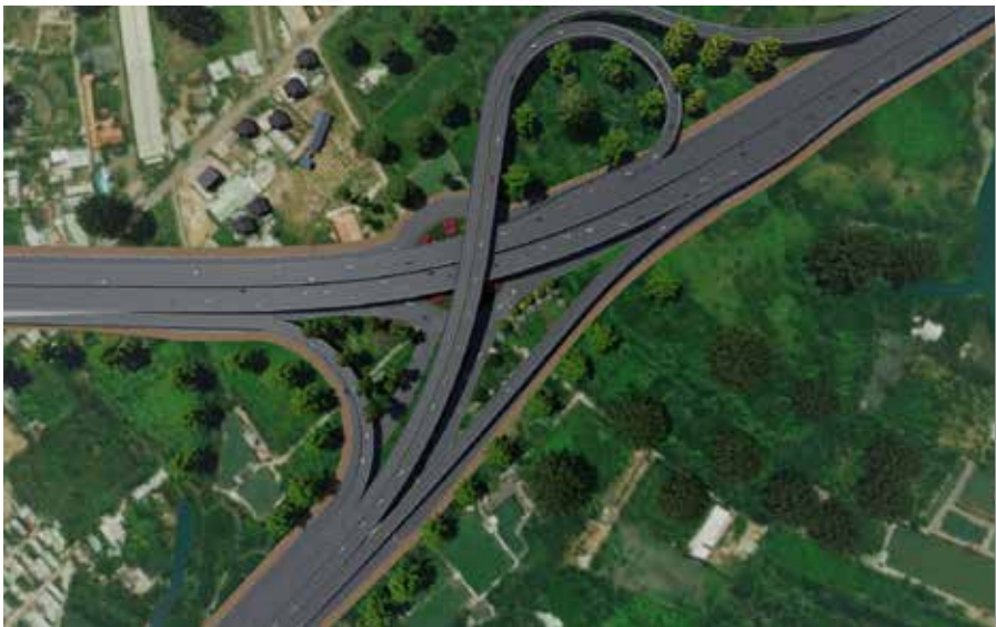
Nút giao và nhánh nối Thủ Đức
